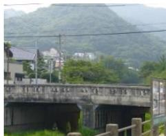
昭和 28 年に設置された開森橋は、その後昭和 38 年までに 2 度の拡幅工事が行われてきました。しかしながら、既に 60 年を経過している部分もあり、経年に伴う劣化・損傷部分の補修が必要な状況になっています。通行車両の大型化に対する耐化力や地震に対するや耐震性なども確保するために、今後の補修事業費等を総合的に勘案し、このたび架け替え工事が行われる事となりました。総工事費用は 3 年間で 2 億 2000 万円。
